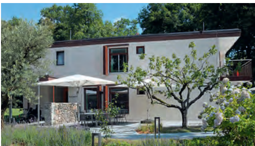
Das behindertengerechte Haus Boscaccio.
